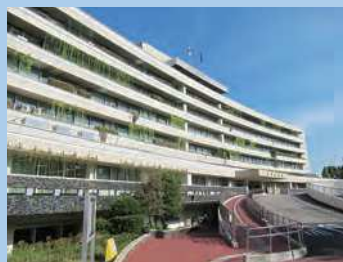
◀新庁舎整備の検討が進む荒川区役所本庁舎
